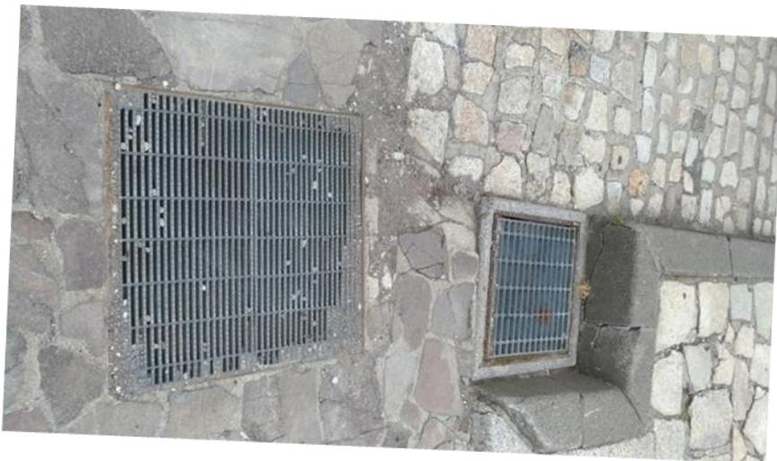
大孔隙與小孔隙的水溝蓋板，小孔隙的蓋板可阻擋雜物進入溝渠，減少垃圾阻塞
