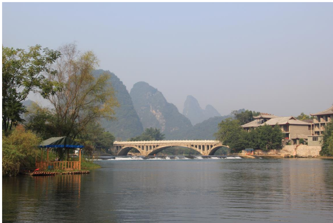
內容說明 | 遇龍江大橋工程
