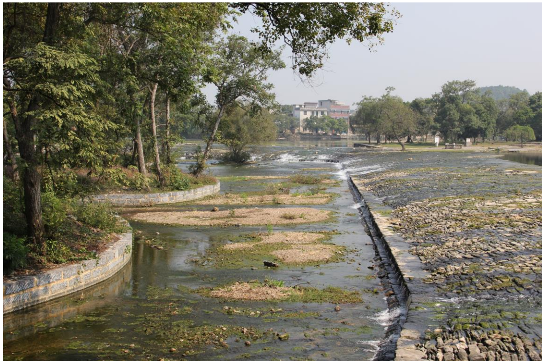
內容說明 | 靈渠水利工程參訪—溢洪口分流
