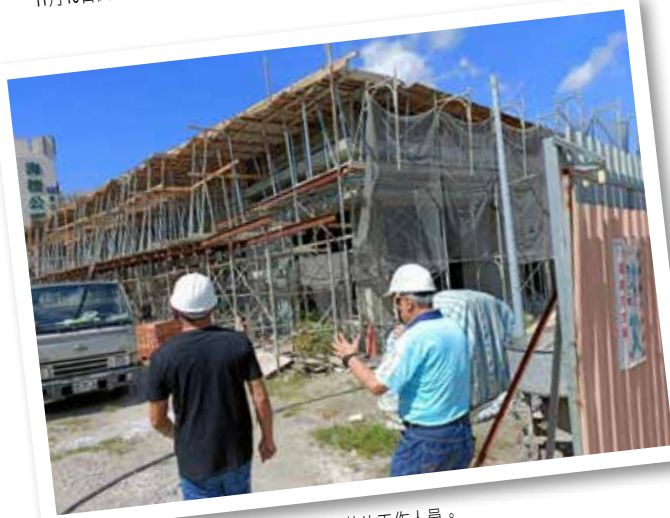
游市長親自到工地現場監工，並慰勞辛苦的工作人員。
