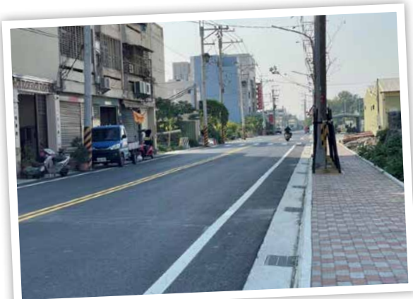
復興路排水系統修繕完工！
