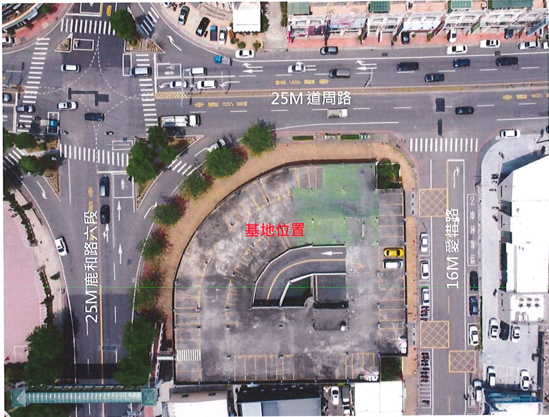
照片32基地及周邊道路空拍照
