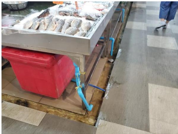
市場的生鮮區，規劃側溝用來處理水的問題，且大部分皆為明溝加高腳落水頭為主，地面乾燥潔淨，排水設施完善，清潔工作徹底，無淤塞沈積及滋生蚊蠅現象。
