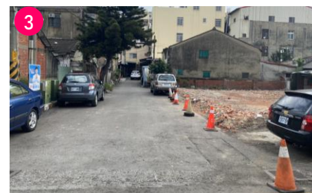
華山路259巷宿舍已拆除
