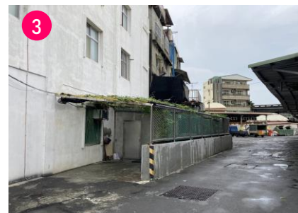
停車場出入空間
