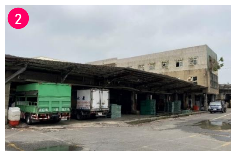
魚貨裝卸空間
