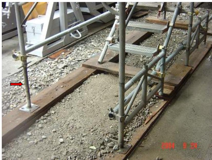
基礎地面應平整、夯實緊密、襯以適當材質之墊材，施工架底部之立架設可調型基腳座鈹，以避免產生不均勻沉陷
