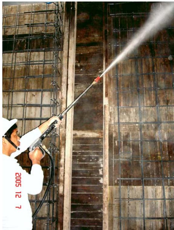
高壓水柱清洗模板土渣
