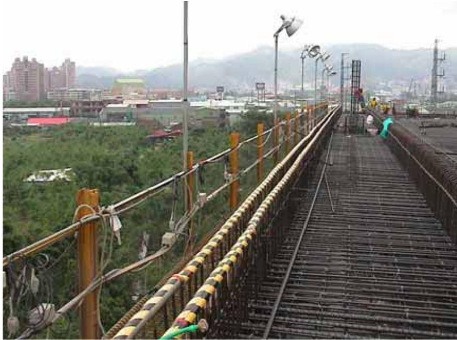
橋面板鋼筋頭用塑膠管保護，並加黃色警示帶，以免造成傷害
