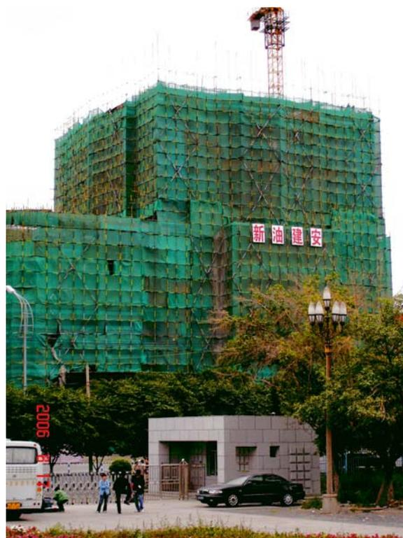
鋼管施工架
