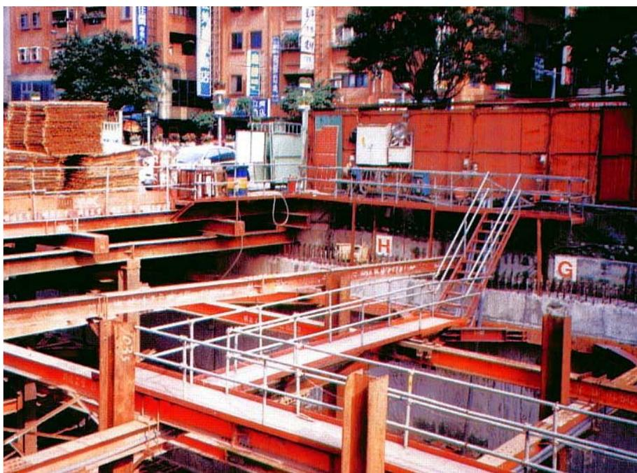
水平支撐上的走道設置扶手
