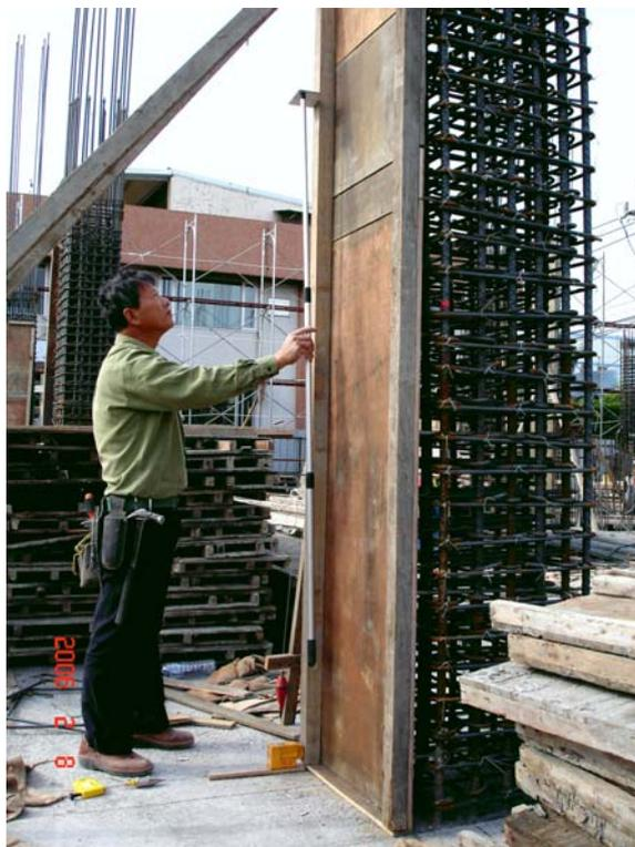
柱牆底端佈設雷射照準儀
