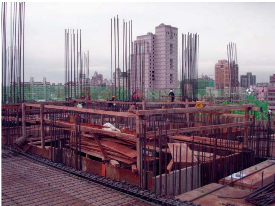
施工樓層的平面開口四周設置欄杆
