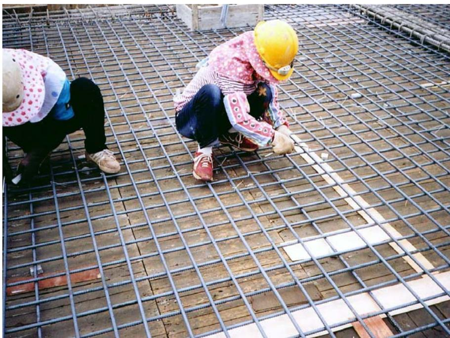
樓版綁紮底層筋與水泥砂漿墊塊隔墊
