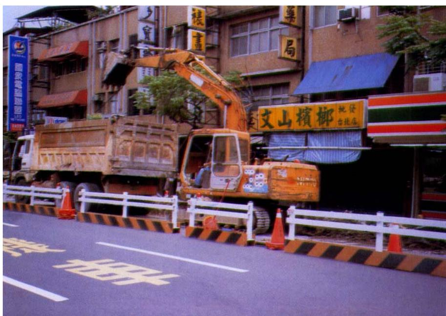
道路施工場所設置槽化的型鋼欄杆管制交通
