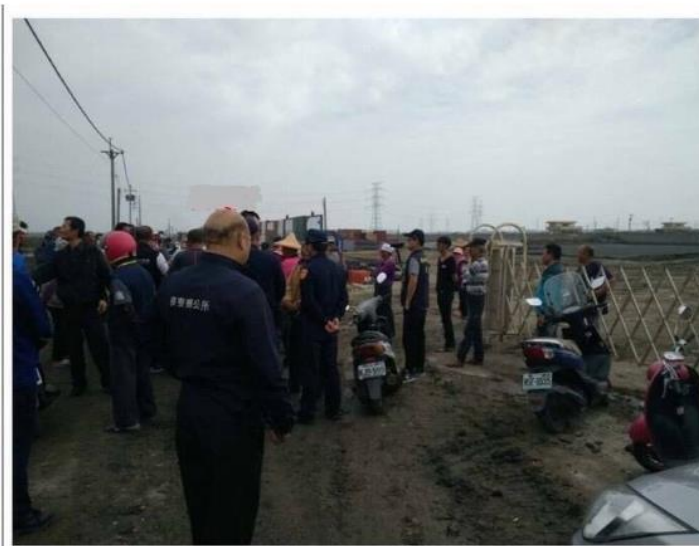
蔡長昆、丁文彬發動村民到施工現場抗議阻止施工，趁機恐嚇取財。(雲林地檢署提供)
