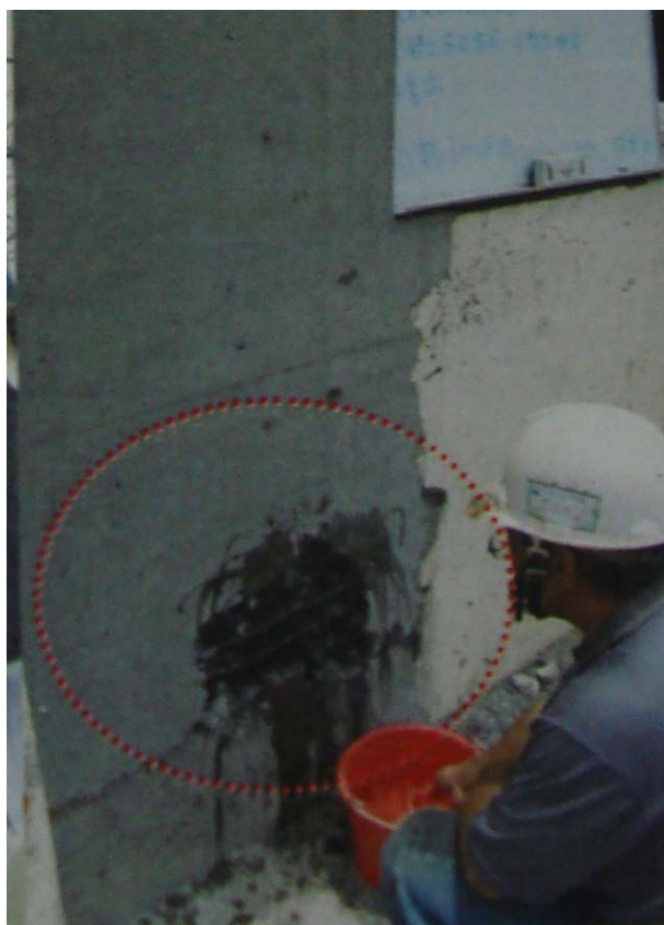
改善中：用水清除鑿除範圍內的碎屑、或粉土
