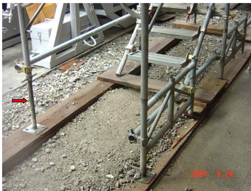
門型施工架搭設斜撐
