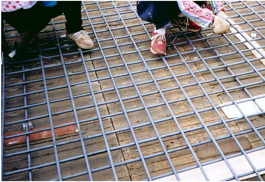
樓版綁紮底層筋與水泥砂漿墊塊隔墊
