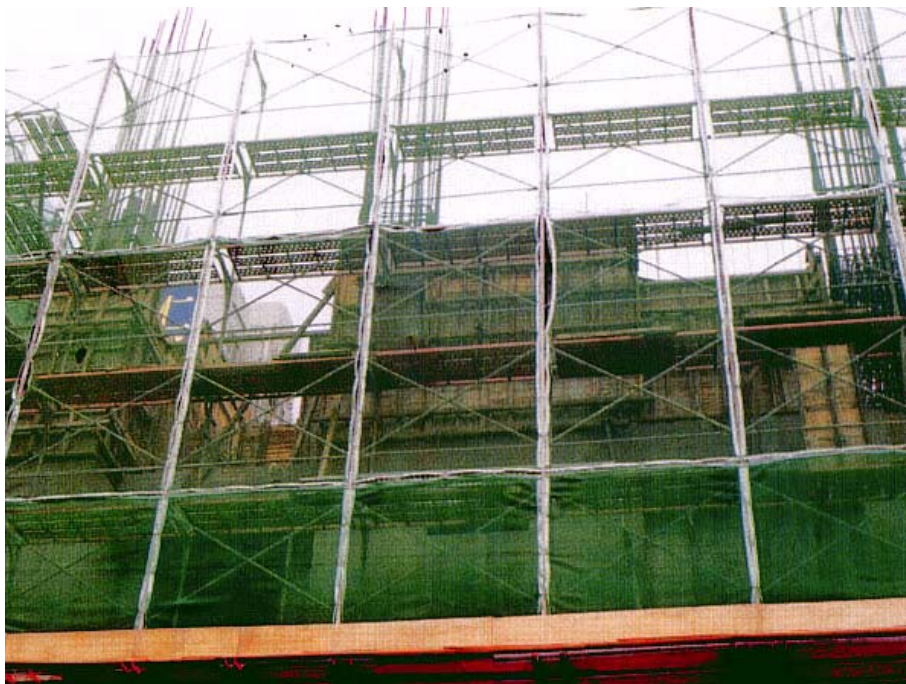
水平桿架設高度約為 45 cm，用萬向活節固定
