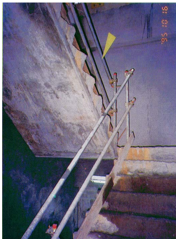
開口處設置防護欄杆
