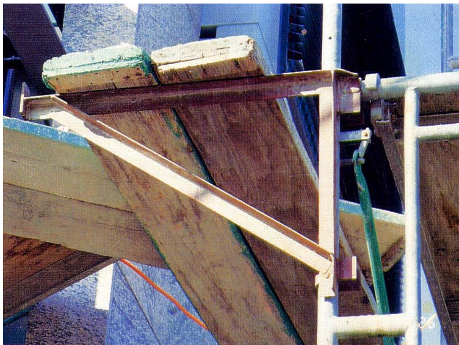
鋪置木料施工架板
