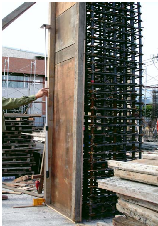
柱牆底端佈設雷射照準儀
