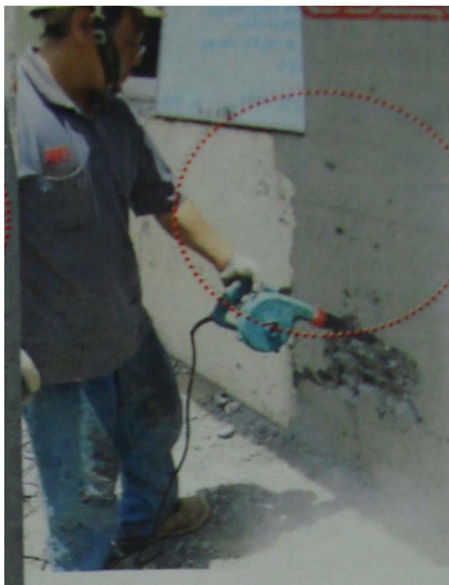
改善中：用高壓空氣清除鑿除範圍內的碎屑、或粉土
