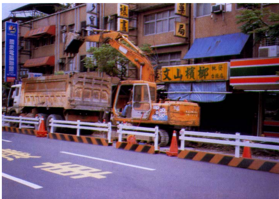
道路施工場所設置槽化的型钢欄杆管制交通
