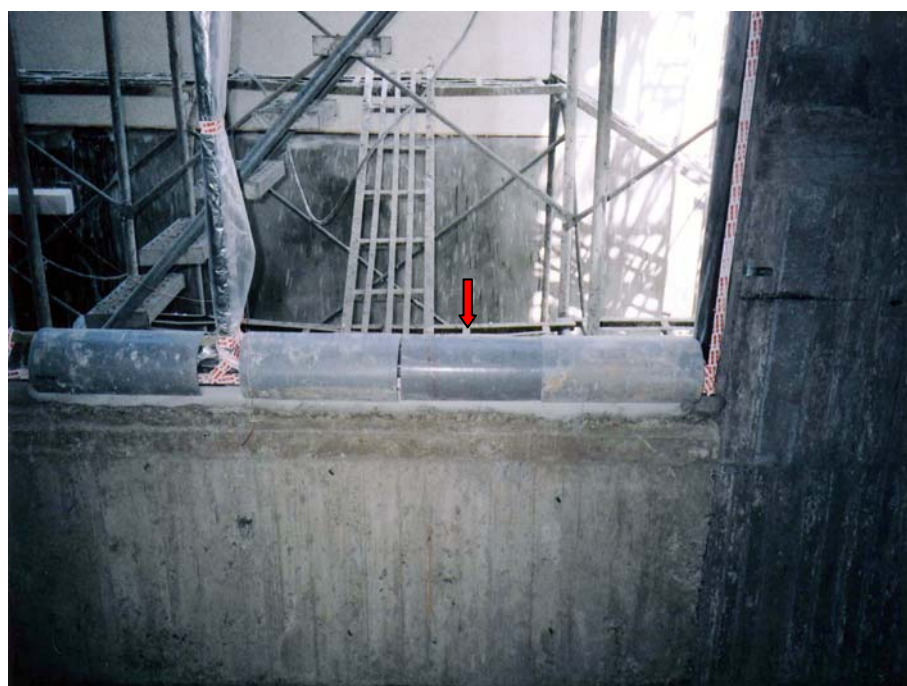
鋁窗下堂料塑膠管改造護蓋
