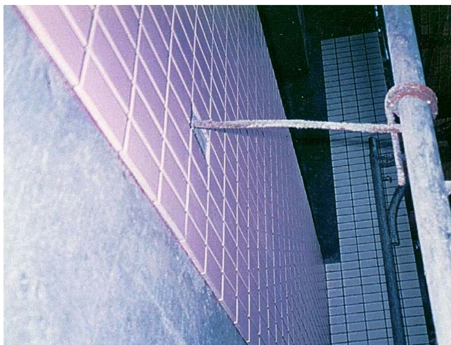
#3 鋼筋環繞腳柱至少 360°
