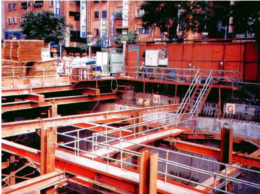
水平支撐上的走道設置扶手
