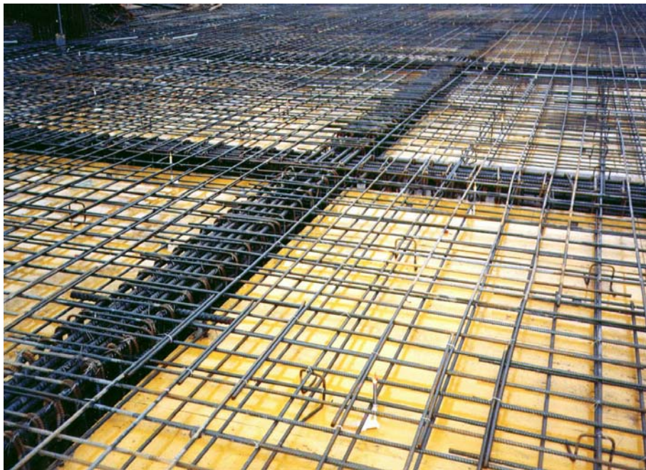
樓版頂層筋使用∩型墊筋
