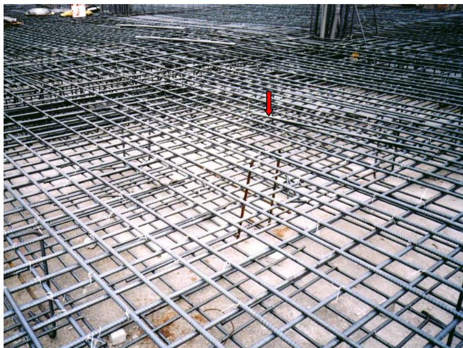
E.S.上下層筋用U型鐵件隔開
