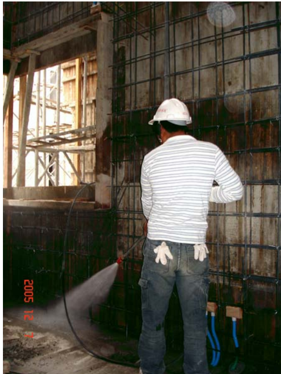
清洗柱牆底雜棄物
