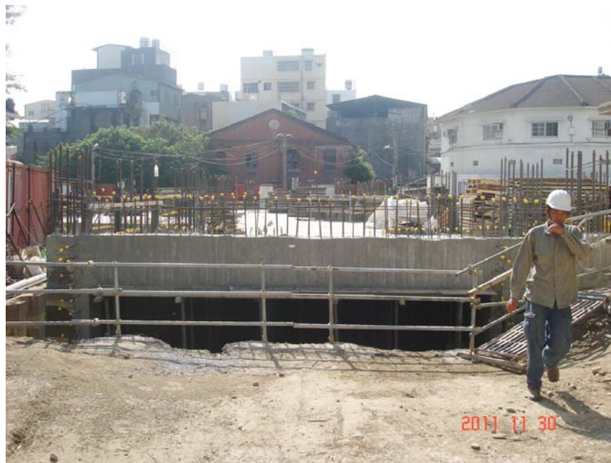
施工樓層開口四周設置欄杆
