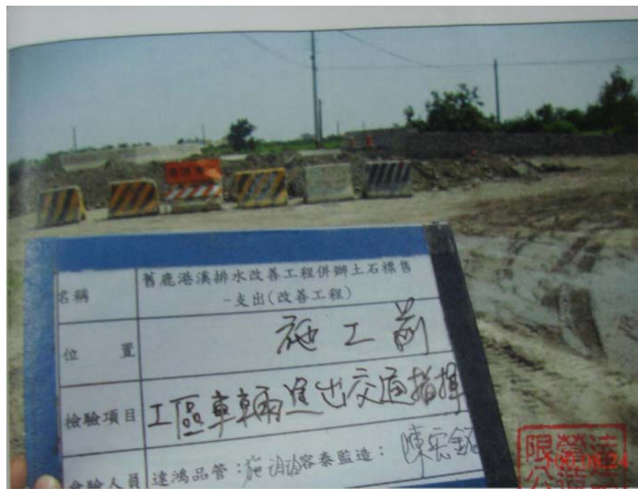
設置紐澤西護欄
