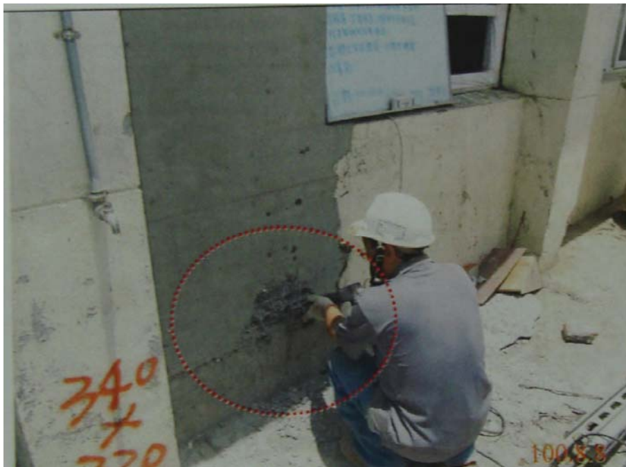
改善中：使用鑿除工具清除疏鬆混凝土
