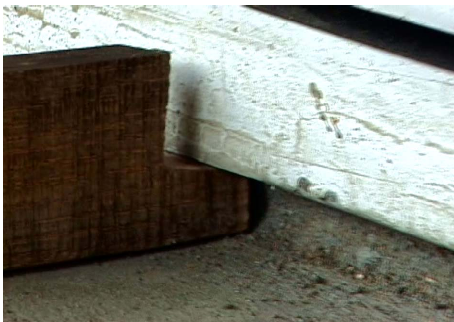
下檁料底端須預設凹槽
