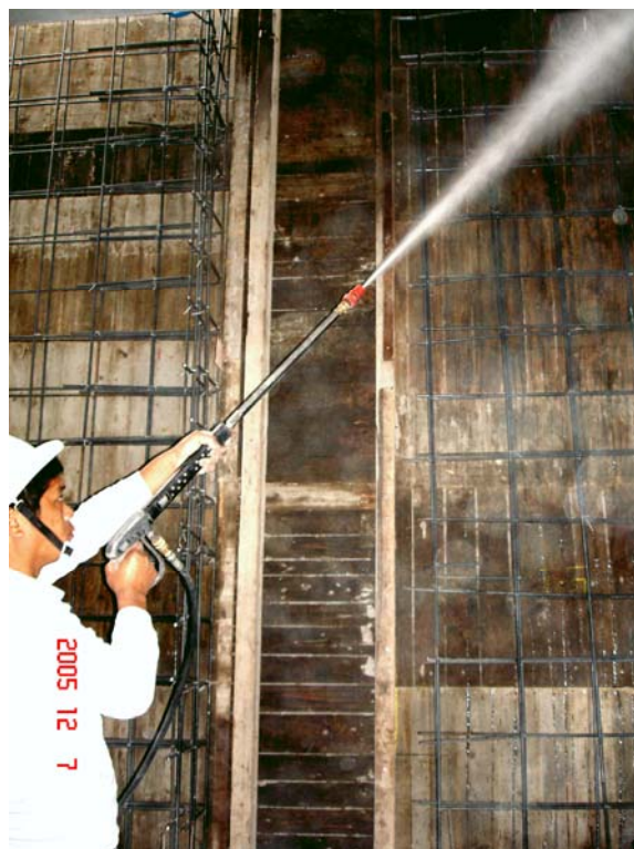
高壓水柱清洗模板土渣
