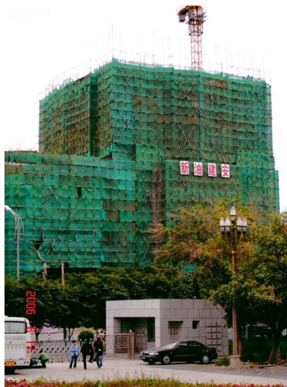
鋼管施工架
