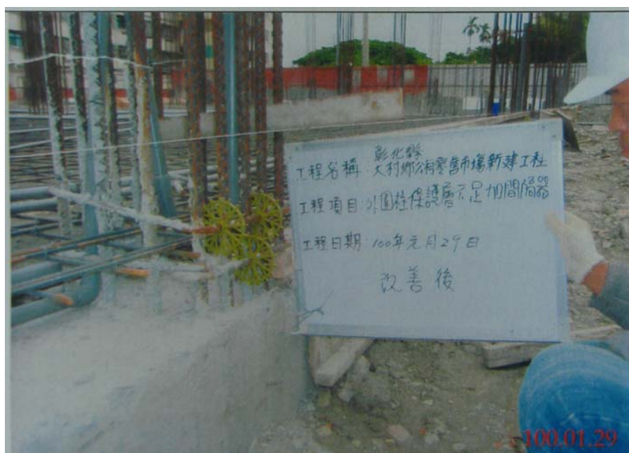
改善後：柱筋保護層確保 4 cm
