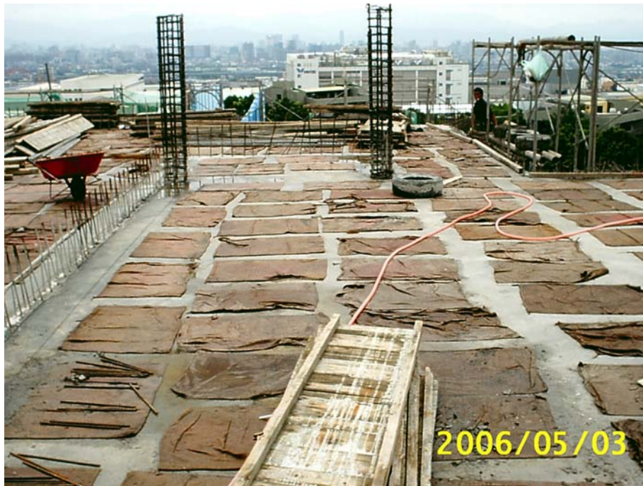
混凝土澆置完成，於 4 小時內鋪置麻布袋後澆水養護
