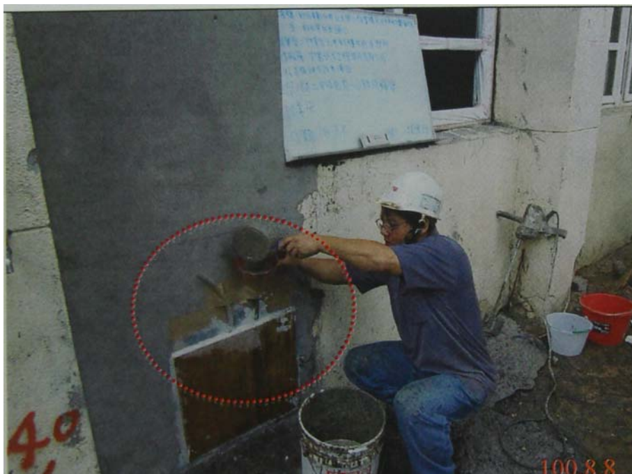
改善中：自開口灌注無縮收混凝土，高度與模板面平齊
