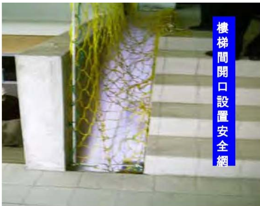
樓梯開口設置安全網
