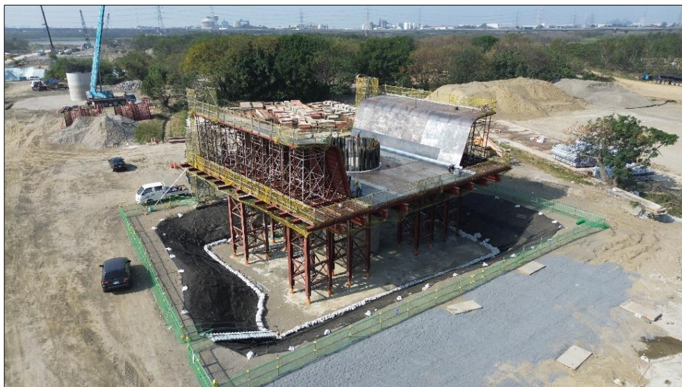
圖 2：臺中大肚－彰化和美跨河橋梁工程墩柱施作情形
