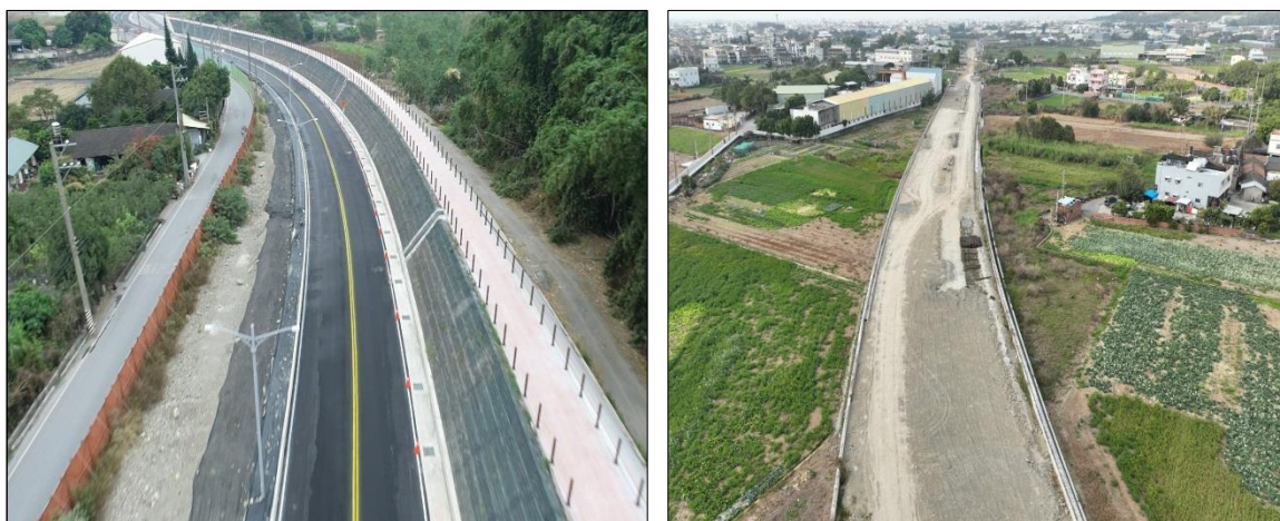
圖 4：東彰道路新闢工程道路南延段及北段施工情形
