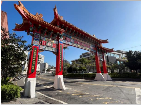
圖 23：八卦山牌樓修繕完成
