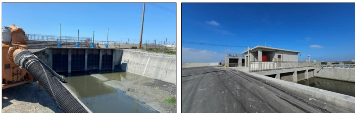
圖 34：外五間窰排水增設閘門式抽水機工程施工前後圖
