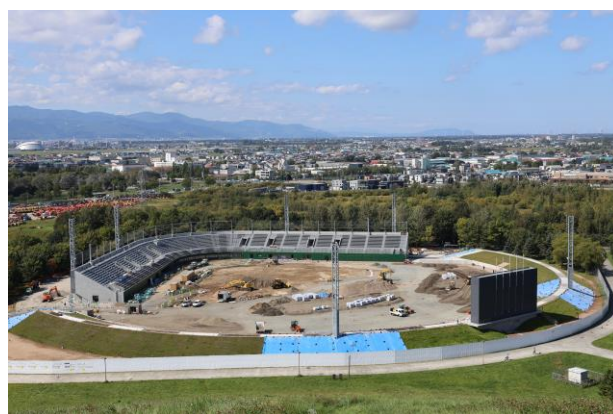
圖 38.目前施工中的建設-球場設施
