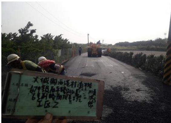
照片二施工中
