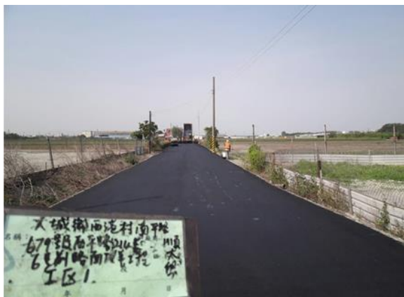
照片二施工中
