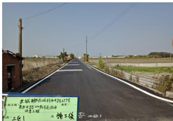
照片三施工後
