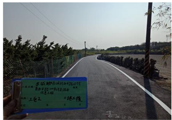
照片三施工後
