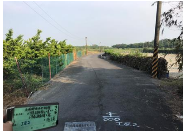
照片一施工前
