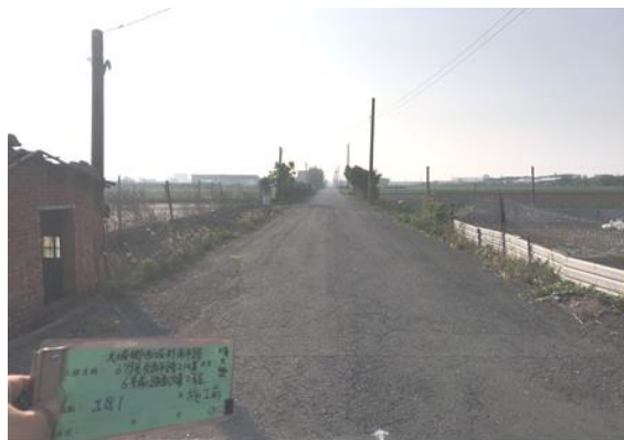
照片一施工前
